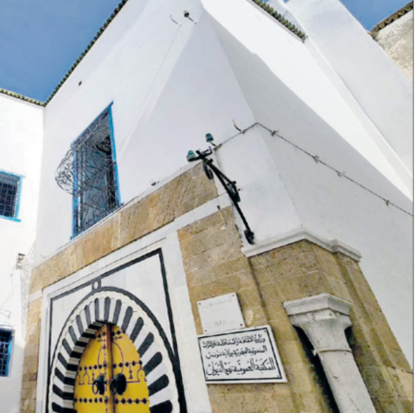
«مكتبة الجوانب، بعد ترميمها (المعهد الوطني للتراث)
