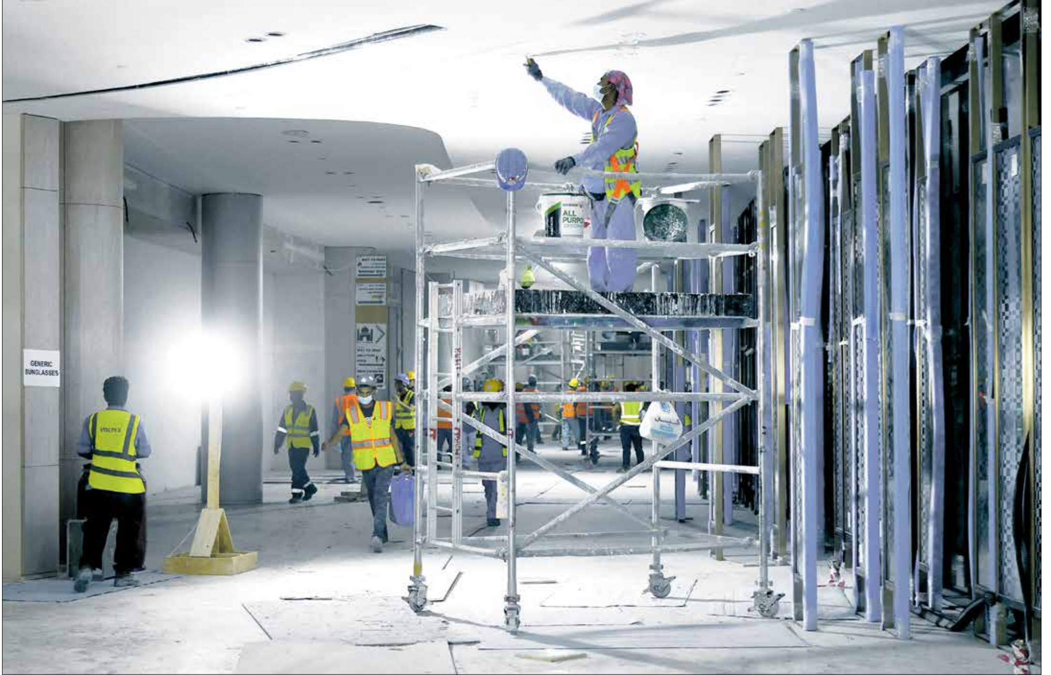
تزايد أسعار مواد البناء يمنع استكمال بناء المنازل (كريم جعفر/فرانس برس)
